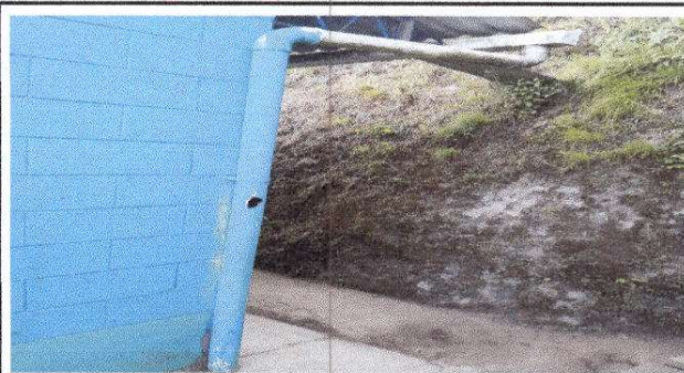
Foto 2: Sustrucción de canal de PVC + Reparación de bajada de agua pluvial, tubo PVC 3"
