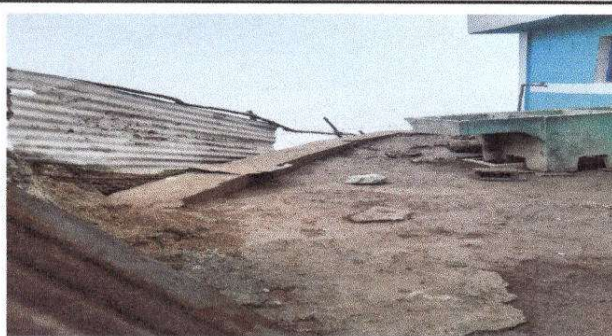
Foto 3: Reparación de planchas de concreto, de patio
