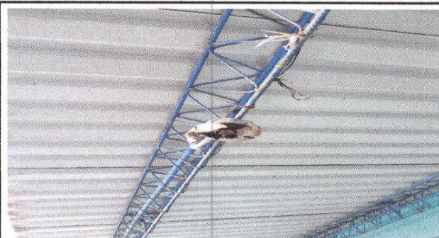
Foto 4: Sustrucción de focos ahorradores + Sustrucción de plafoneras + Sustrucción interruptores dobles + Reparación de cableado eléctrico
